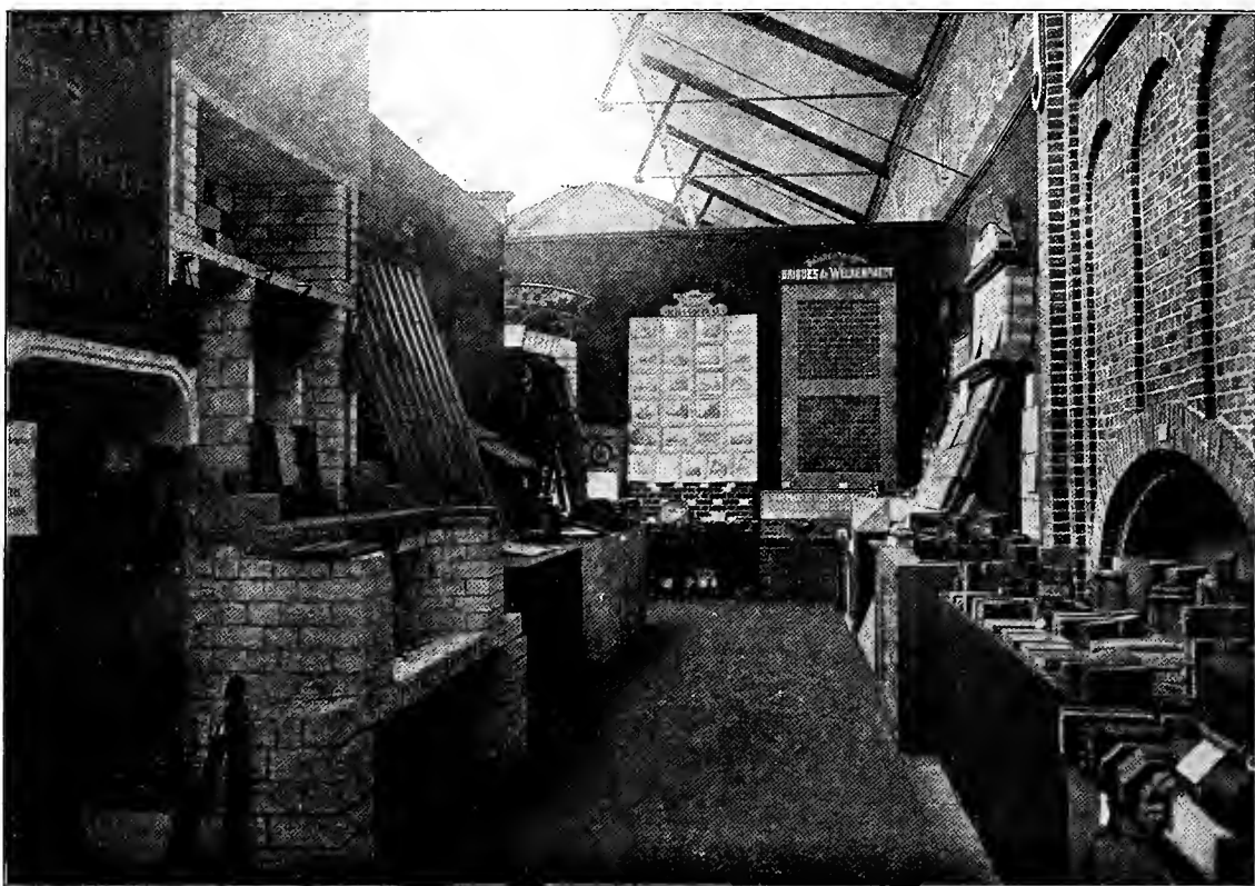
LE PAVILLON DU GÉNIE CIVIL. — UNE VUE INTÉRIEURE.
